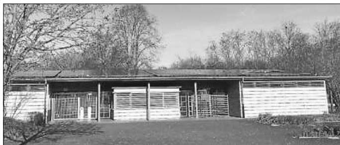
Installierte PV-Module auf dem Dach Eingangsbereichs im Freibad
