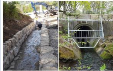
Einlaufbauwerke mit optimiertem Rechen
