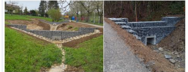
Geröllfang mit Retentionswirkung
