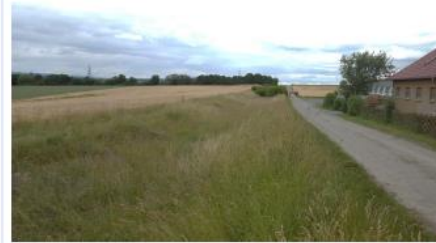
Retentionsgraben mit Ackerrandstreifen
