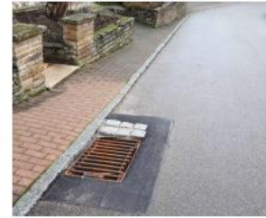
Bergeinlauf (mit Optimierung)
