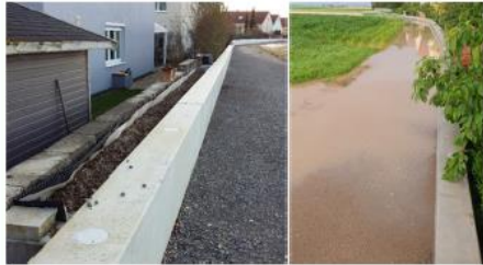
Mauer mit Rückhalt
