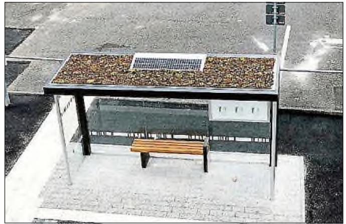
Auch Feinstaub und Luftschadstoffe werden gefiltert, im Substrat gebunden, abgebaut und von den Pflanzen aufgenommen. Die Fahrgastunterstände bestehen aus Aluminium – davon sind 80 % aus recycelten Aluprofilen – Glas und dem nachwachsenden Rohstoff Bambus.
