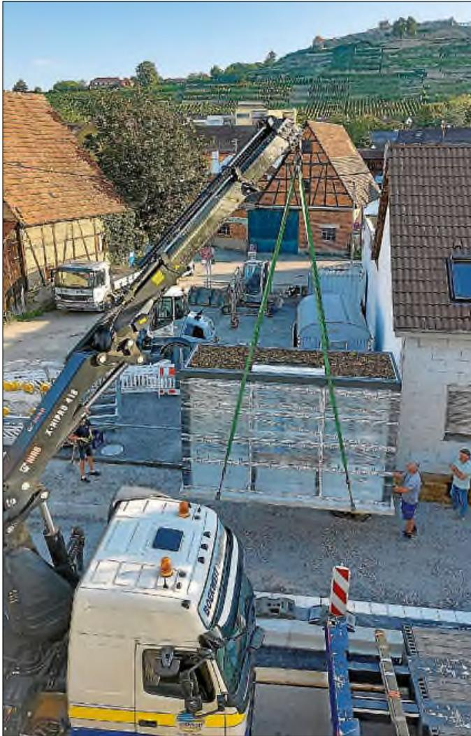
Schnelle und einfache Montage durch die Fachfirma aufgrund der bereits fertig montierten Grundplatte.
