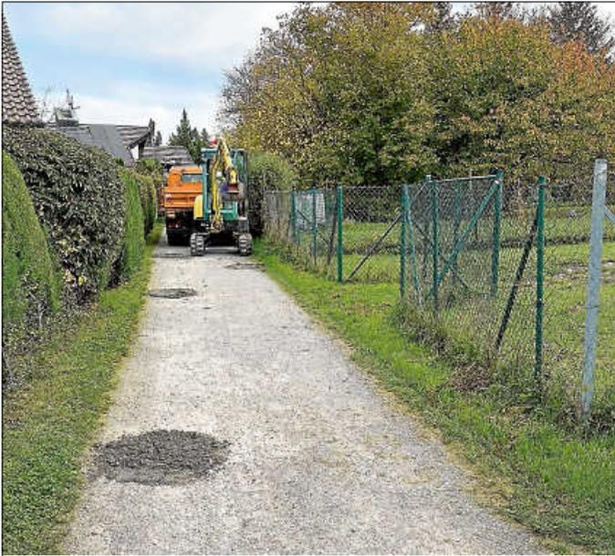
Die Feldwege werden dabei mit einem besonderen Material ausgebessert. KFT ist ein Gebinde aus kombiniertem Frostschutz und Tragschicht und wird ohne Bindemittel, nur verdichtet aufgetragen. Die Oberfläche wird dadurch wasserdurchlässig und gleichzeitig auch besonders tragfähig.
